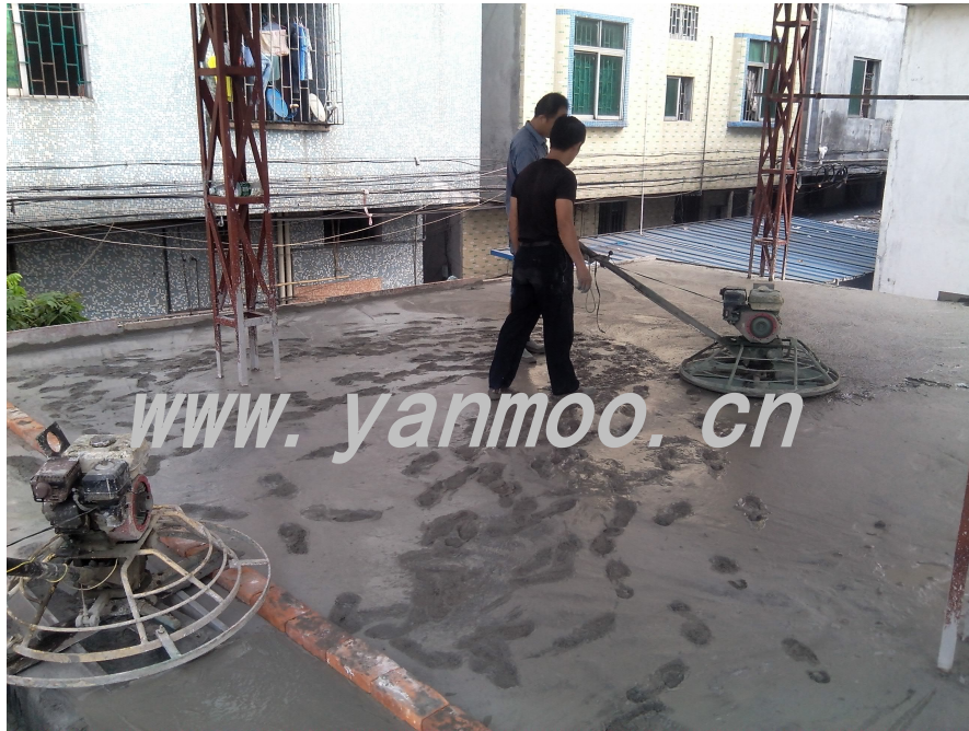
第一次铺撒金刚砂
