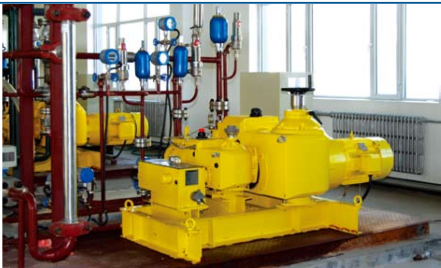
■ 油田：三元复合驱技术采油 碱/表面活性剂/聚合物投加
