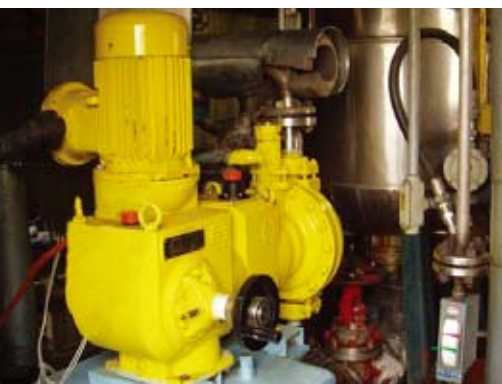
■ 石化：高压聚乙烯装置 过氧化物引发剂投加
