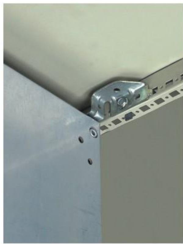
安装板上固定件
