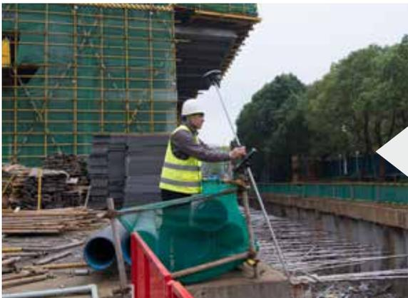
测量点在大型机械旁，或者在高压电线下？面对高强度的电磁干扰，常规的倾斜补偿又能如何作业？
