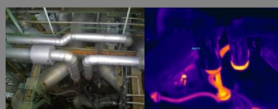
● 管道安全巡检
