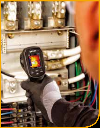
电气故障检修
