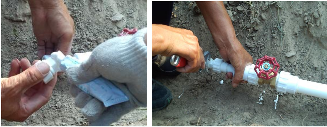
蒸发皿桶安装管路
