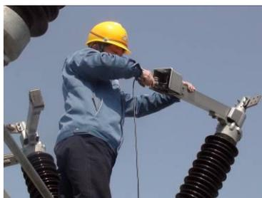
第三步 测量触指压力
