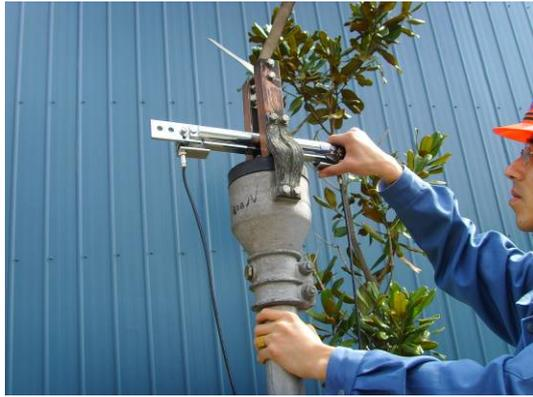
第三步 测量触指压力
