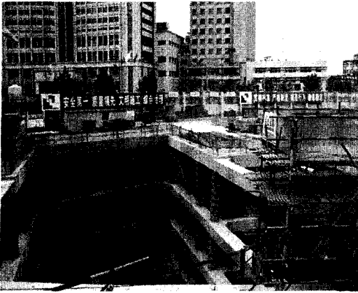
图 4 四层地下室结构现场施工图
