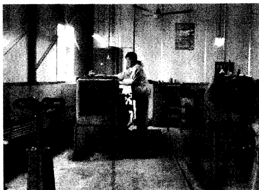
图 2 防水套管加工现场
