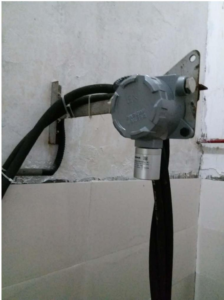
就深国安气体检测仪来说，固定式的可以有三种采样方式，扩散式、管道式、泵吸式；便携式的气体检测仪也有三种采样方式，扩散式、泵吸式、探杆式。
