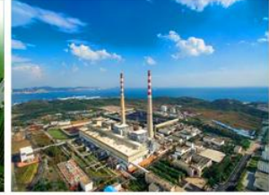
大连甘井电子氨气检测项目
