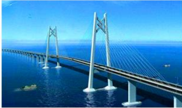
港珠澳大桥联检楼气体检测项目
