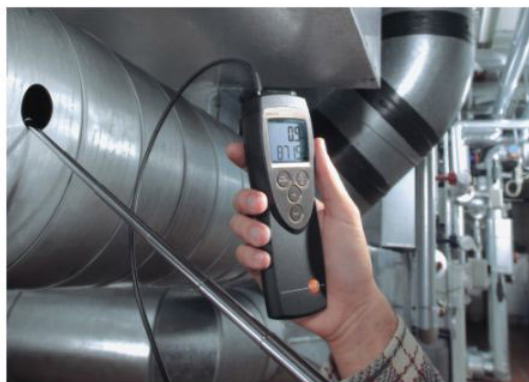
testo 425, 检测排风口的风量
