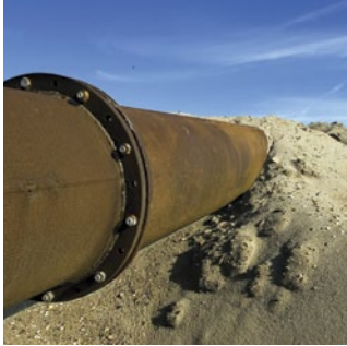
穿越道路的埋设管道
