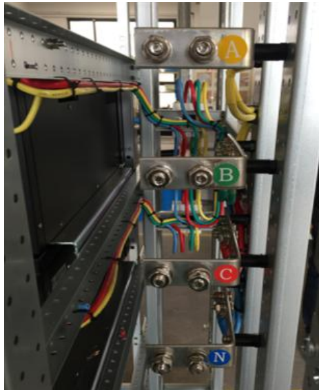
图 2-13 汇流排接线示意
