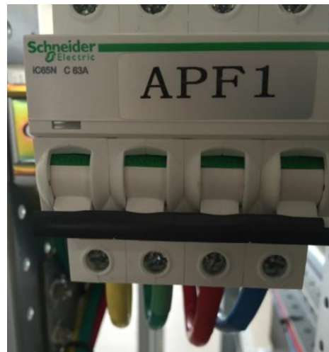
图 2-12 微型断路器接线示意
