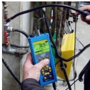
工程技术人员使用超声波检漏仪小范围寻找漏点
