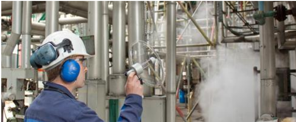
工程技术人员使用超声波检漏仪大范围寻找漏点
