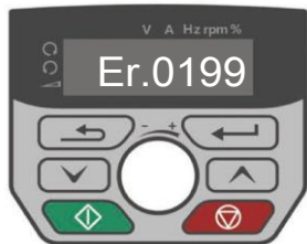
图 4-4 故障告警显示状态
