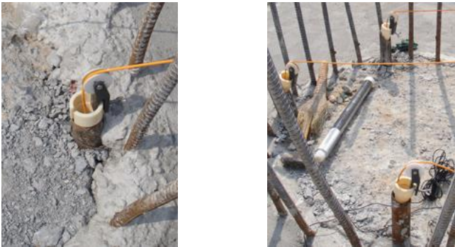
图 F1.2 管口滑轮安装
