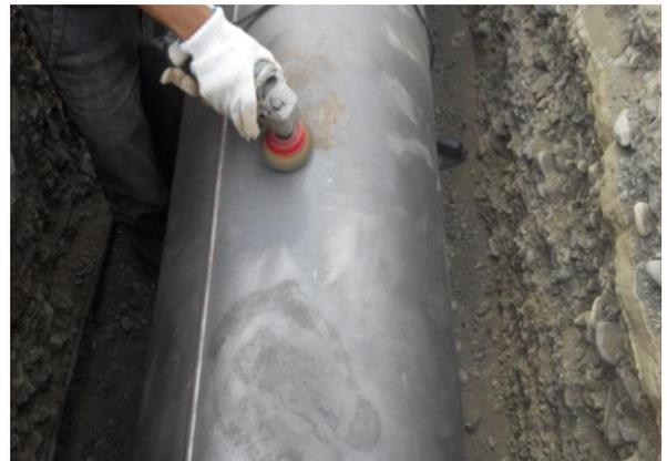
开挖后对破损点管体进行打磨除锈
