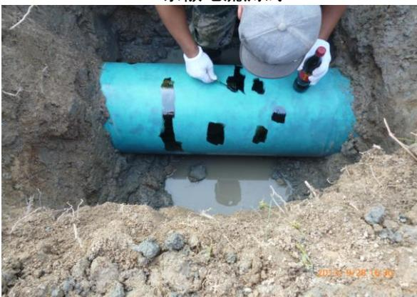
对防腐层破损处进行修复
