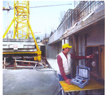
现场开关柜安全测试
