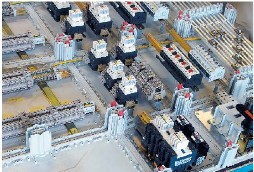
完全开放性的结构,可以快速安装电盘内的部件。
