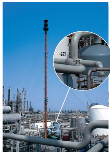
GF868现场的典型安装示意。详图显示传感器安装在通往火炬罐的火炬气主管上
