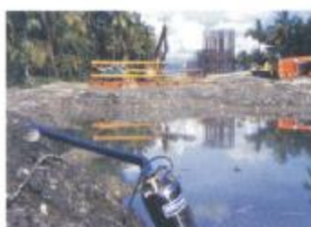
营造工地移动排水
