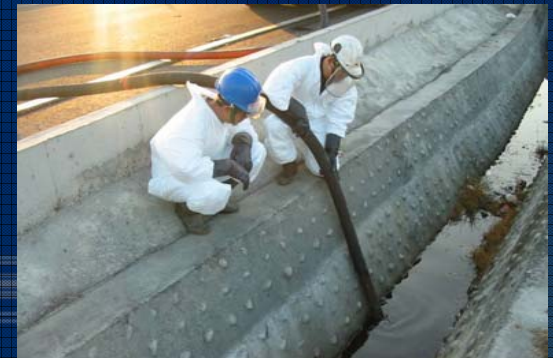
消防水抽除作業
